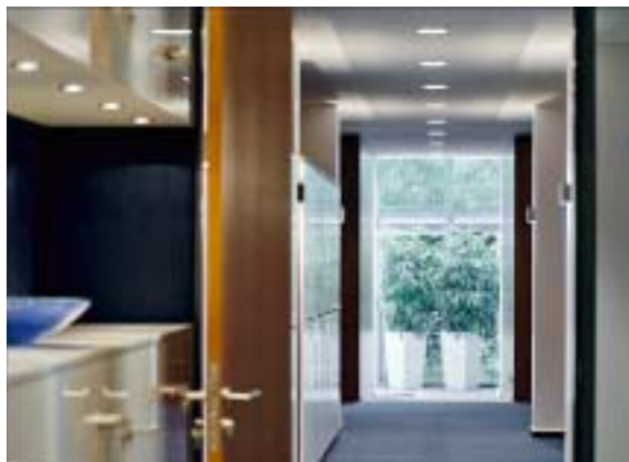
/ Aus Holztrennwänden wurden Ganzglasanlagen, um Licht in die fensterlose Halle zu bringen.
